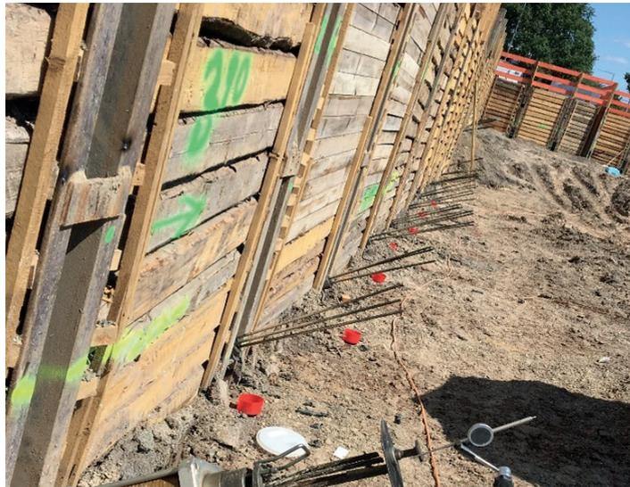
Spannen von Litzenanker mit Ankerzement® hergestelltem Verpresskörper
