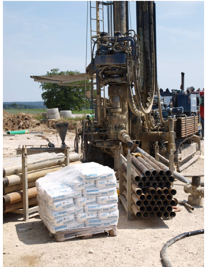
Bohrung einer Erdwärmesonde
