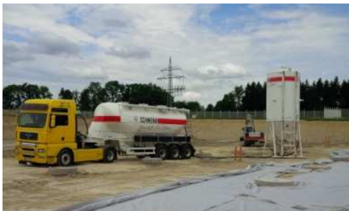
Lieferung von Füllbinder® EWM im Silofahrzeug
