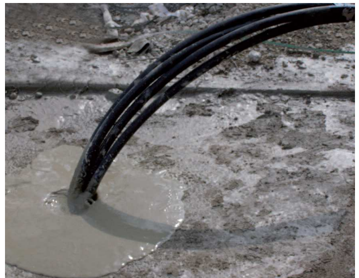
Mit Füllbinder® EWM verfülltes Bohrloch
