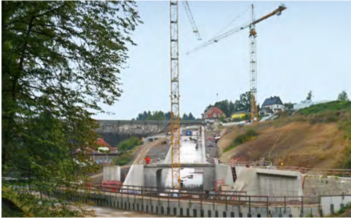
Hochwasserentlastung einer Talsperre, hergestellt mit CEM III/A 32,5 N-LH (na)
