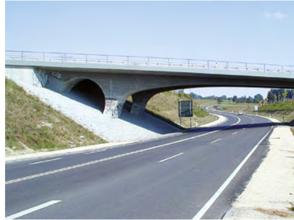
Brücke, hergestellt mit Portlandkalksteinzement CEM II/A-LL 32,5 R
