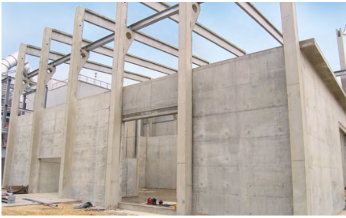
Industriehalle, betoniert mit CEM II/A-M (V-LL) 42,5 N
