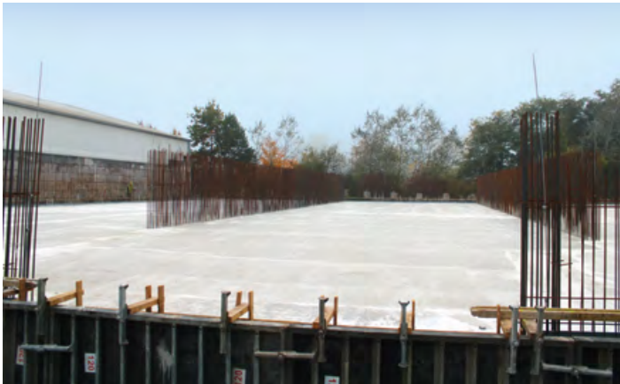
Bodenplatte Lagerhalle SCHWENK Zement Karlstadt, hergestellt mit CEM III/B 42,5 N-LH/SR
