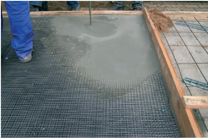
Bild 4: Einsatz von Duracrete® basic im Infiltriermörtel des Ducon®-Systems für Industriefußböden
