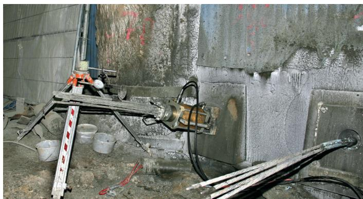
Spannen von Litzenanker mit Ankerzement® hergestelltem Verpresskörper
