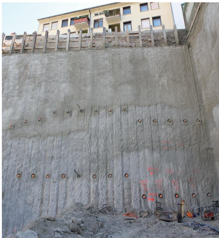
Mit Ankerzement® rückverankerte Bohrpfehlwand
