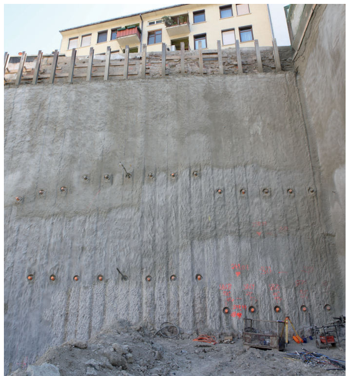
Mit Ankerzement® rückverankerte Bohrpfehlwand
