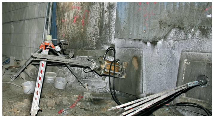
Spannen von Litzenanker mit Ankerzement® hergestelltem Verpresskörper
