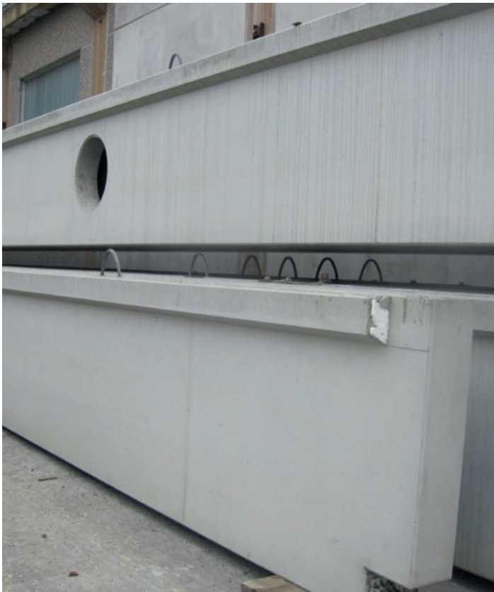
Bild 8: Spannbetonelemente – Verkürzte Umspannzeiten bei Spannbeton
