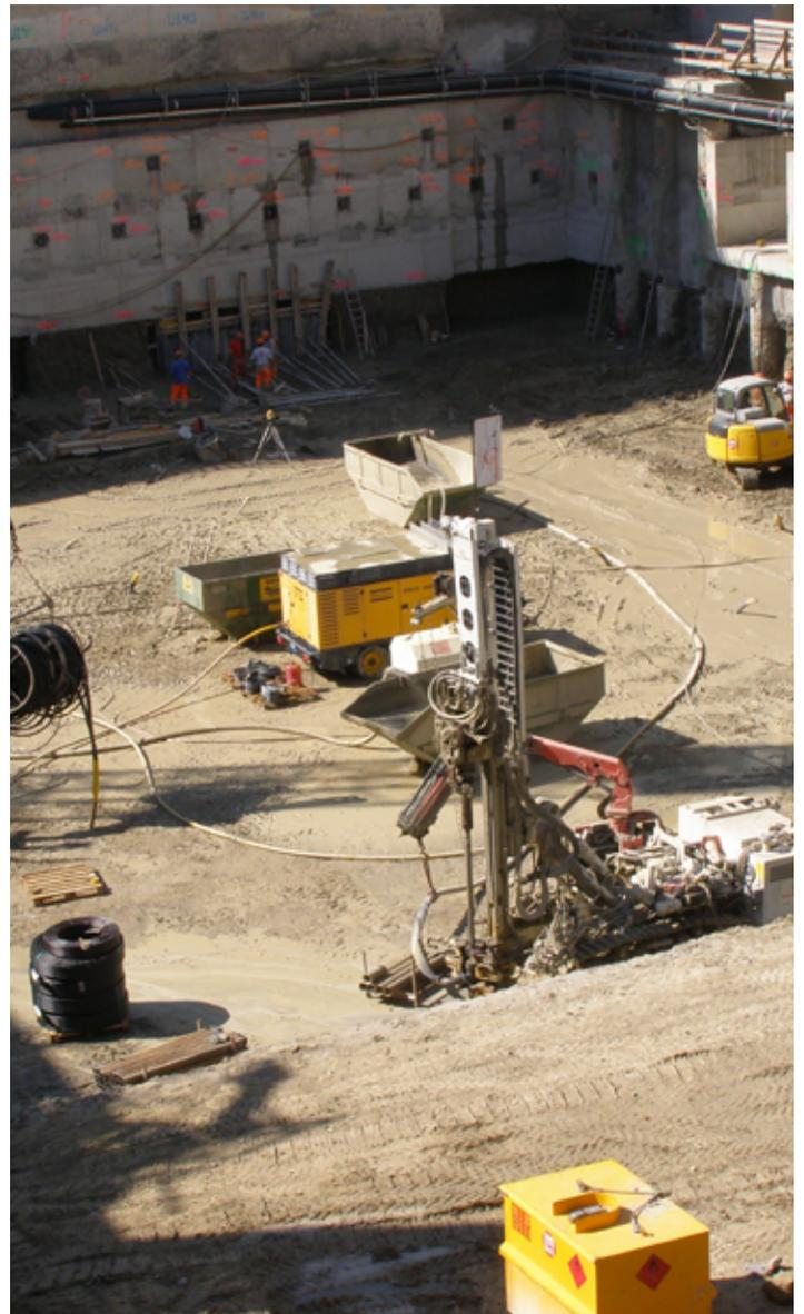
Ringraumverfüllung von Erdwärmebohrungen mit Füllbinder®
