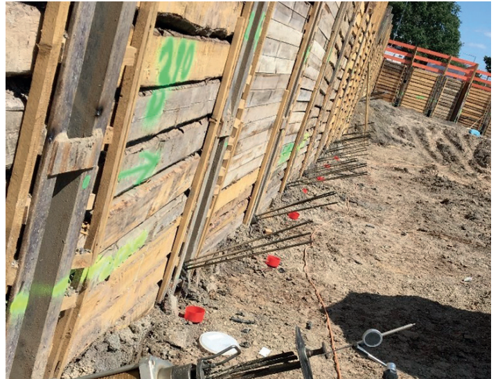
Spannen von Litzenanker mit Ankerzement® hergestelltem Verpresskörper
