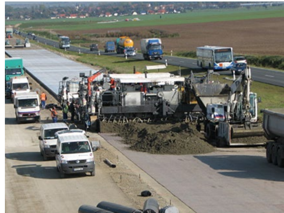
Straßenbau Oberbeton, hergestellt mit CEM III/A 42,5 N (na)
