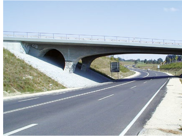
Brücke, hergestellt mit Portlandkalksteinzement CEM II/A-LL 32,5 R
