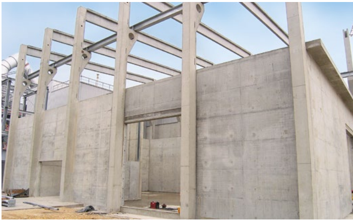
Industriehalle, betoniert mit CEM II/A-M (V-LL) 42,5 N
