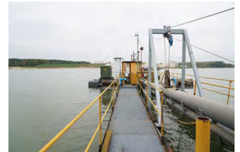
Schwimmbagger Werk Borgsdorf | SCHWENK
