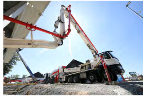
Betonpumpe mit sicherem Stand BPD Vogtland | SCHWENK
