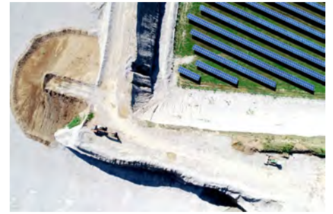
Folgenutzung: PV-Anlage in Kiesgrube Darast
