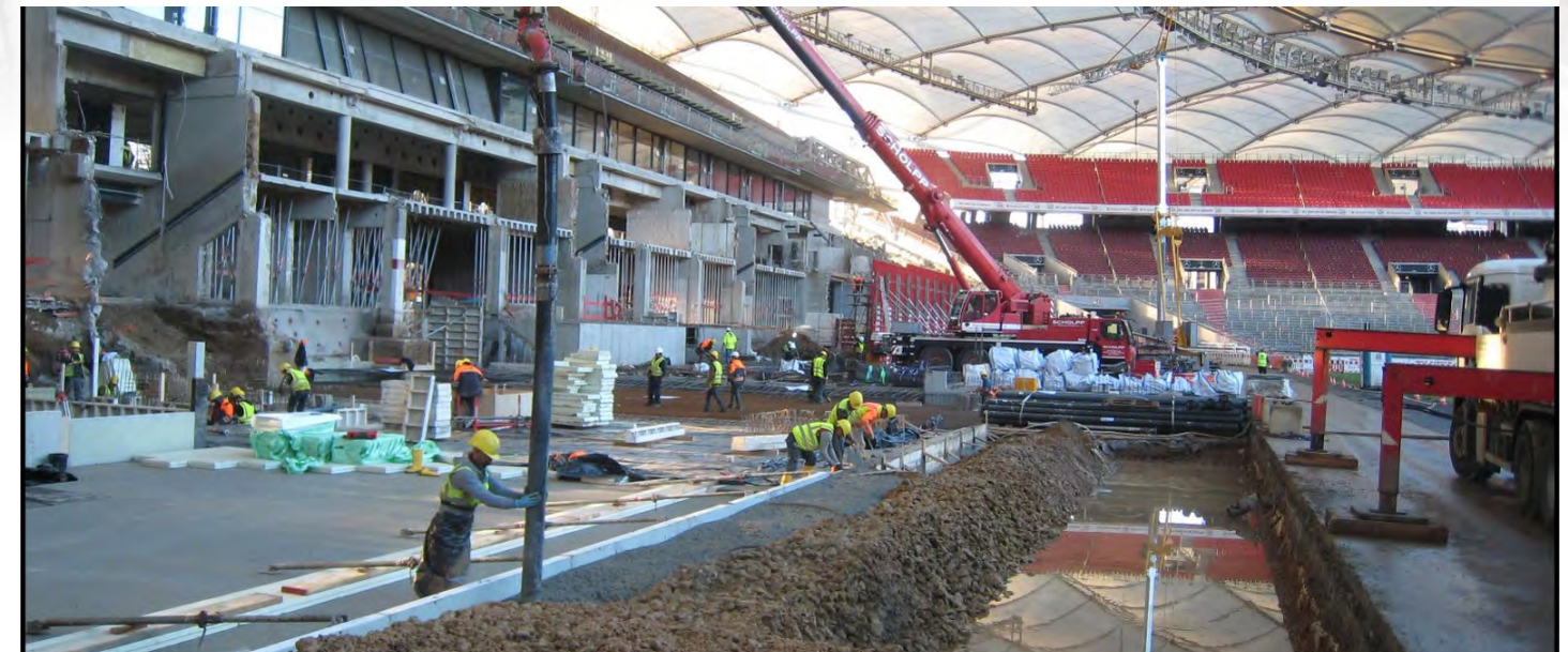
Bild: Baustelle Mercedes-Benz Arena
