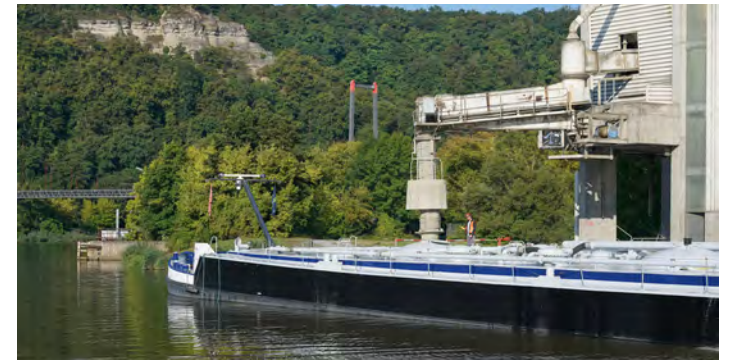
Hafen im Zementwerk Karlstadt | SCHWENK
