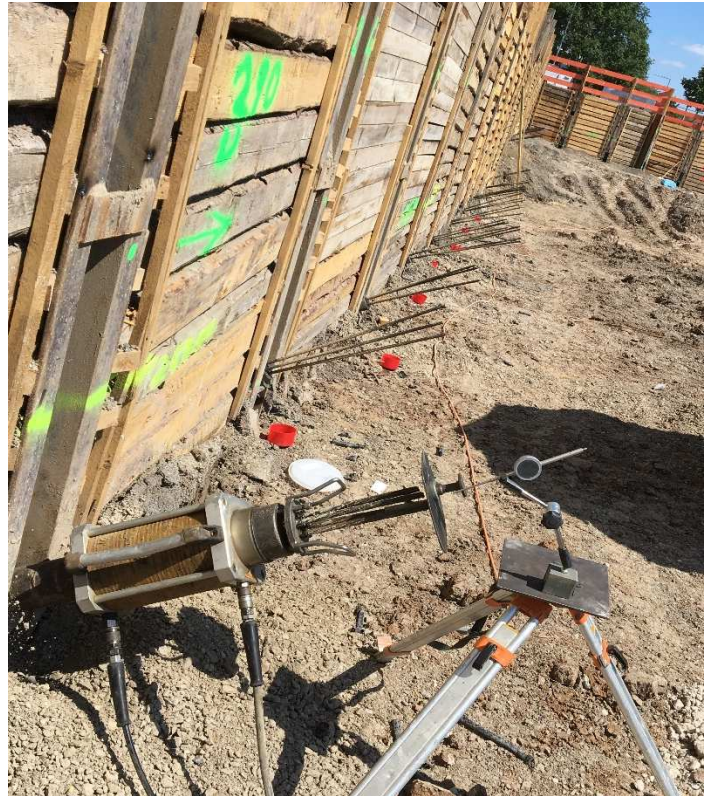
Spannen von Litzenanker mit Ankerzement® hergestelltem Verpresskörper
