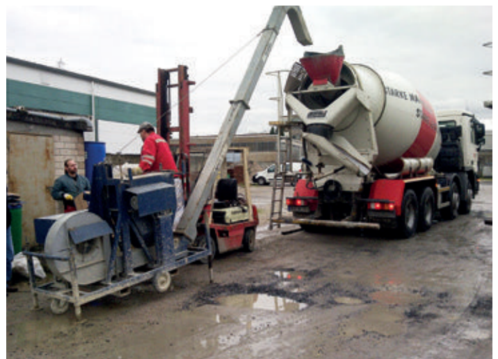
Bild 5: Dosierung der Stahlfasern in den Fahrmischer
