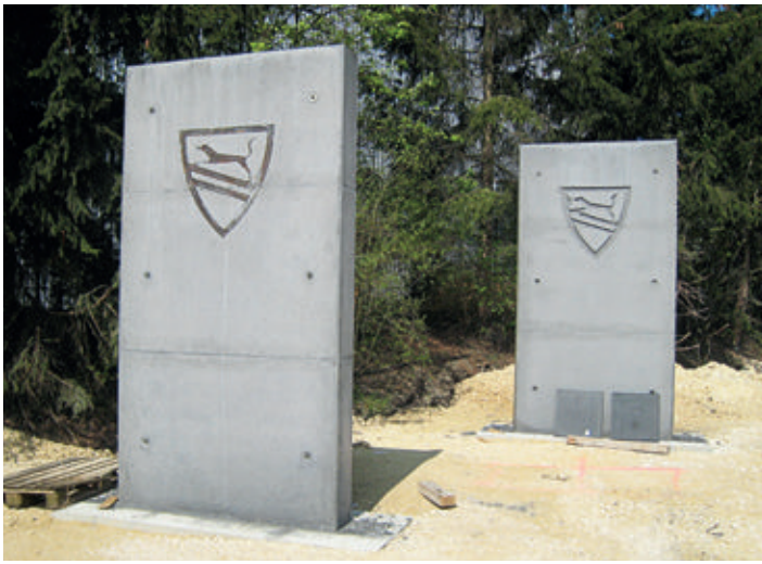
Bild 2: Musterwände auf der Baustelle
