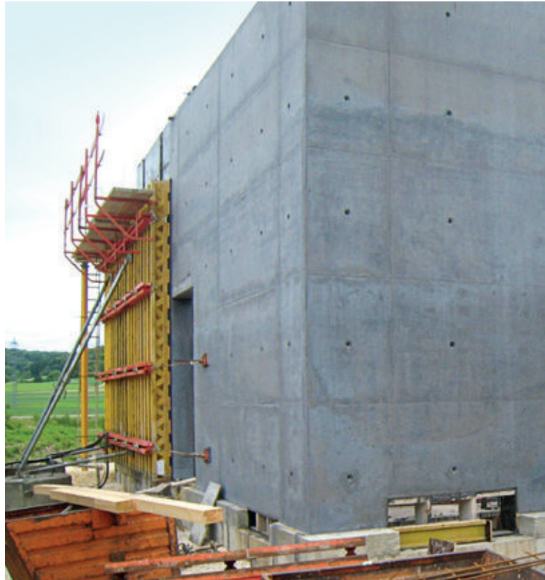
Bild 4: Sichtbetonwände nach dem Ausschalen
