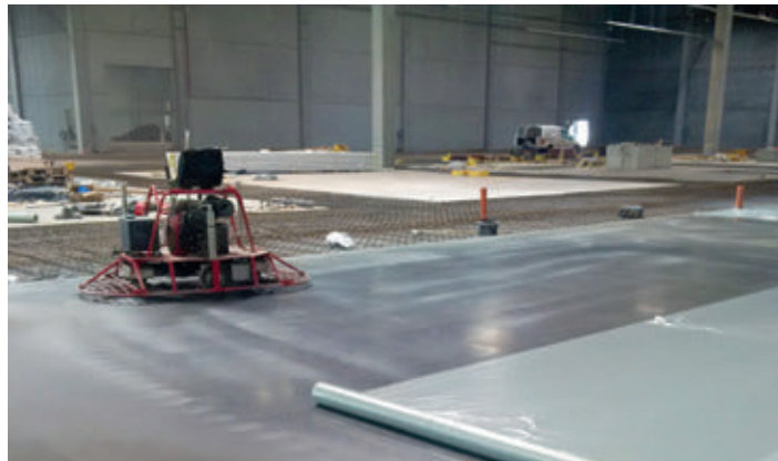
Bild 7: Sofortige Nachbehandlung des Betons nach dem Glätten
