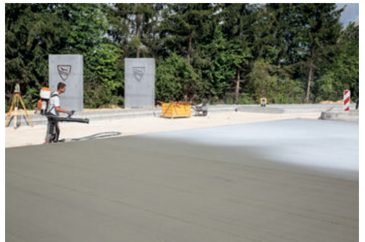
Bild 3: Nachbehandlung mittels Curingauftrag
