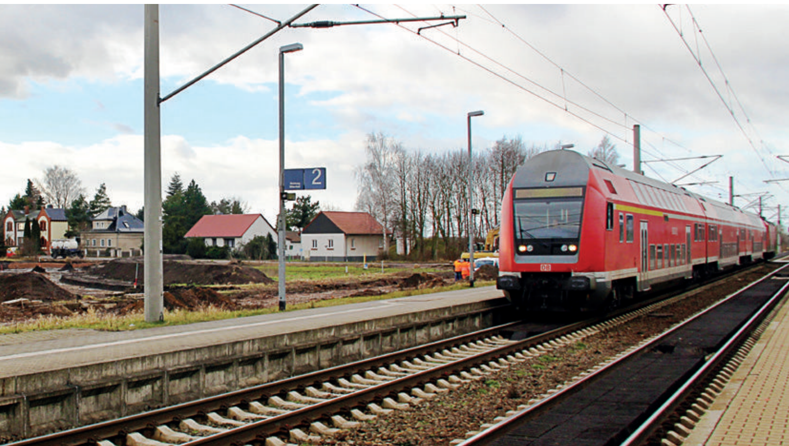
Bild 1: Bahnübergang Ortslage Hohenthurm
