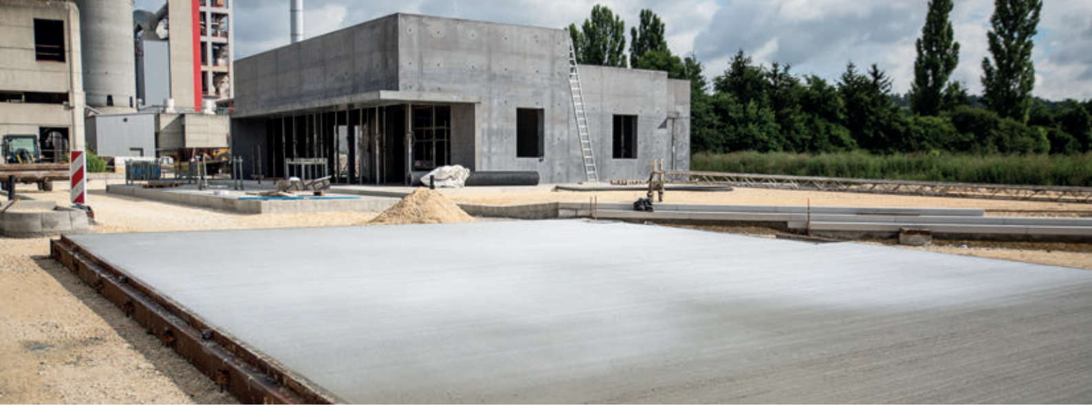
Bild 7: Betonoberfläche mit flüssigem Nachbehandlungsmittel
