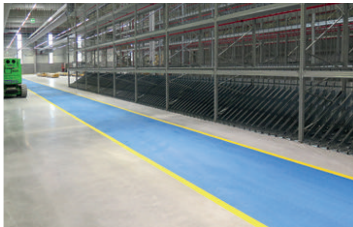
Bild 9: Fertiger Boden noch vor Inbetriebnahme
