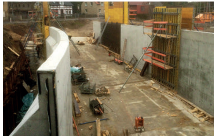
Bild 3: Schalung Trogbauwerk Nord
