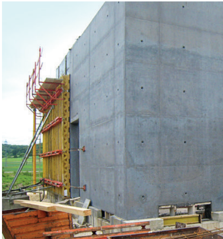
Bild 4: Sichtbetonwände nach dem Ausschalen
