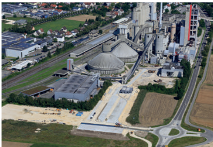
Bild 4: Luftbild des Standorts Mergelstetten
