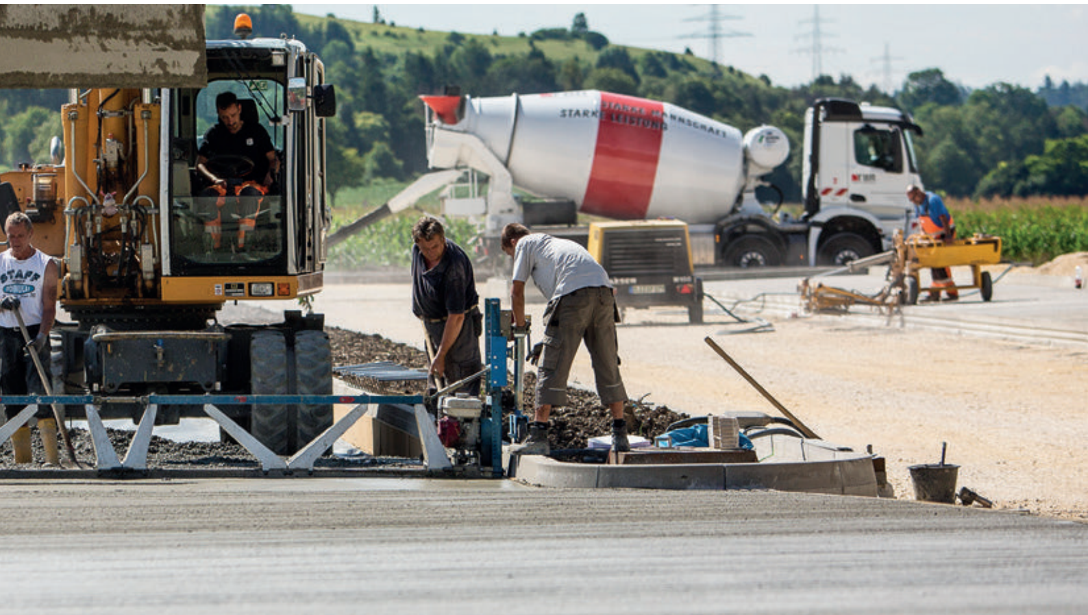
Bild 1: Einbau einer Verkehrsfläche aus Beton
