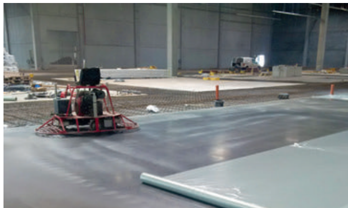
Bild 7: Sofortige Nachbehandlung des Betons nach dem Glätten
