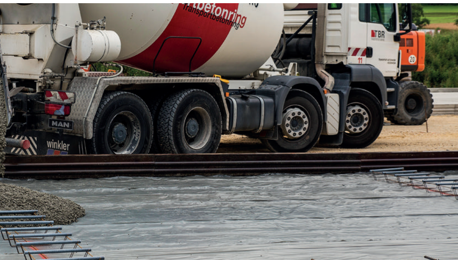
Bild 1: Lagesicherung der Dübelkörbe
