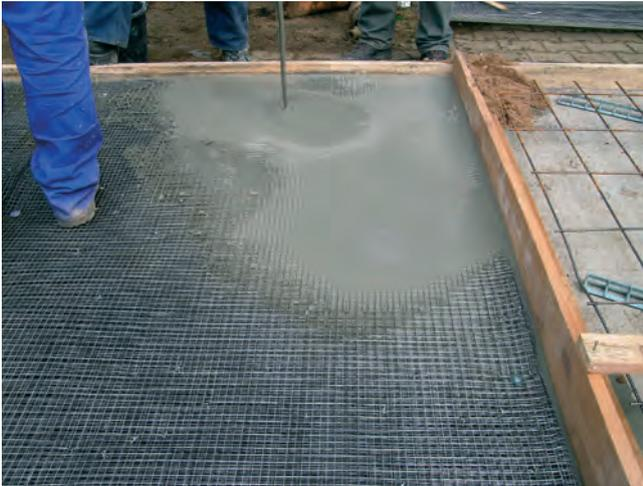
Bild 4: Einsatz von *Duracrete® basic* im Infiltriermörtel des Ducon® - Systems für Industriefußböden
