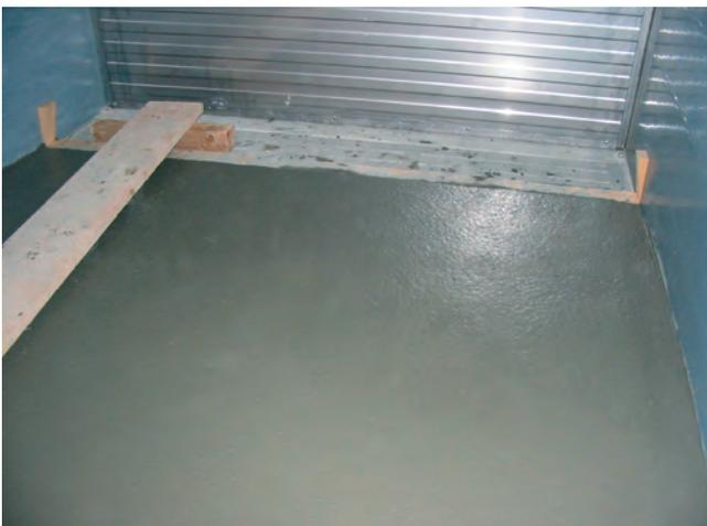
Bild 8 und 9: Einsatz von ***Duracrete*<sup>®</sup> *basic*** für dichte Betone im landwirtschaftlichen Bauen, z.B. Stallbau
