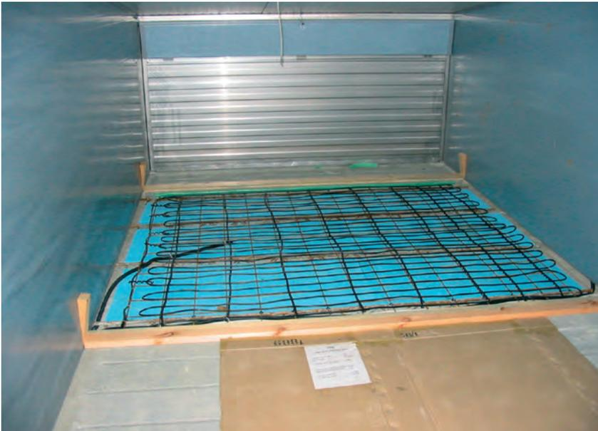
Die Fußbodenkonstruktion eines Ferkelaufzuchtstalles wird durch die Expositionsklassen XC3, XA1 und XM1 beansprucht. Durch die Verwendung von ***Duracrete*<sup>®</sup> *basic*** kann die Lebens- und Nutzungsdauer wesentlich verlängert werden.
