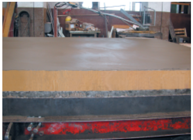
Bild 4: Nach 1,5 h mit Flügelglätter geglättete Oberfläche von Beton mit Fastcrete® plus
