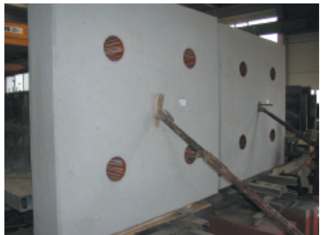
Bild 10: Fundamente – Rationeller Fertigungsablauf bei tiefen Temperaturen
