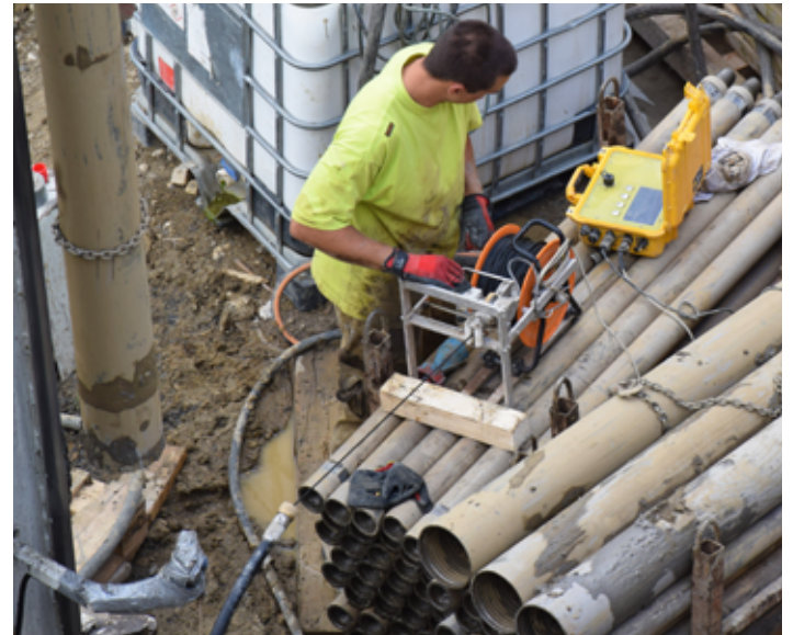
Befahren der Sondenrohre zur Messung der Bohrlochverfüllung
