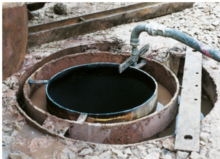
Verfüllung des Brunnenringraumes mit Füllbinder®
