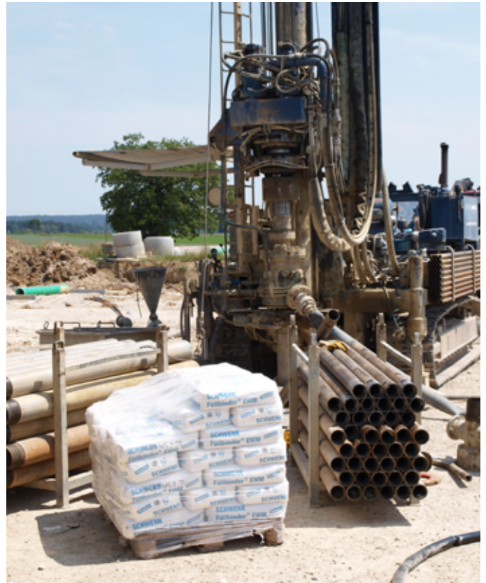
Bohrung einer Erdwärmesonde
