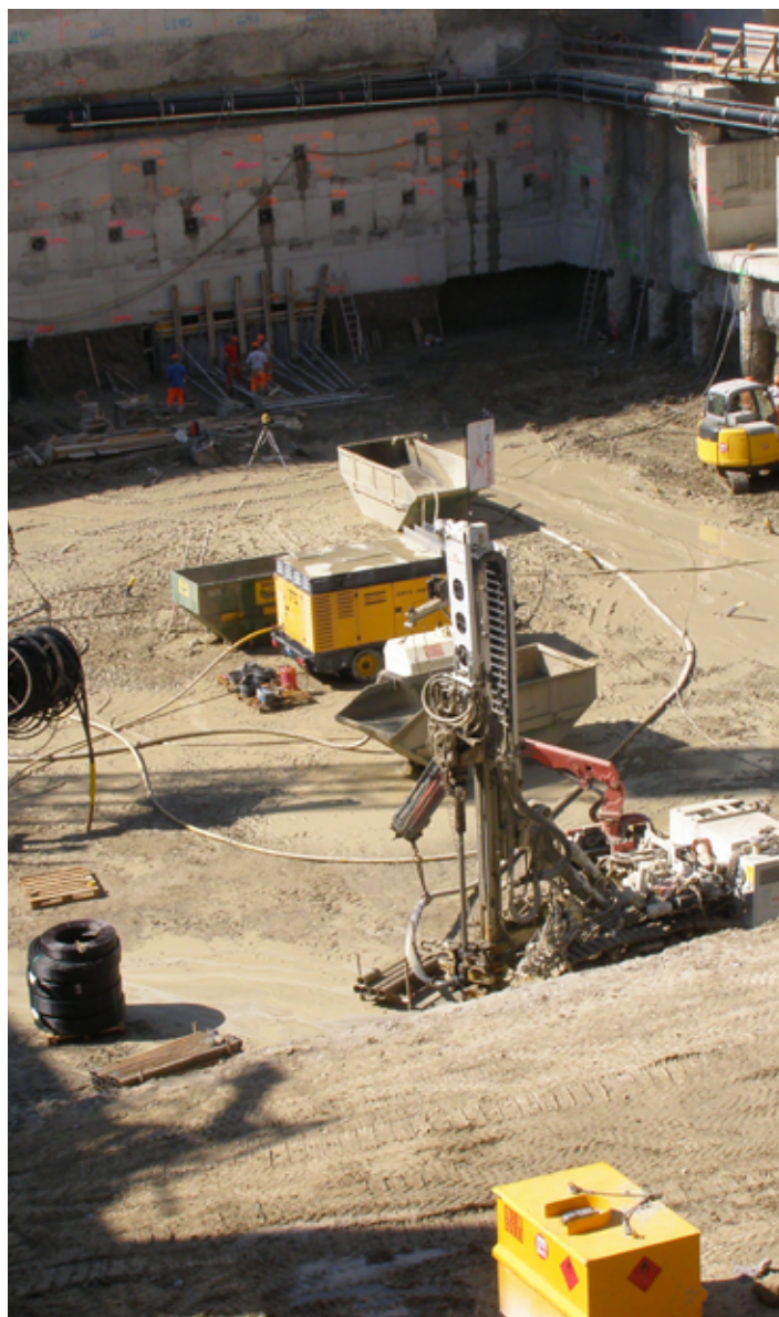
Ringraumverfüllung von Erdwärmebohrungen mit Füllbinder®
