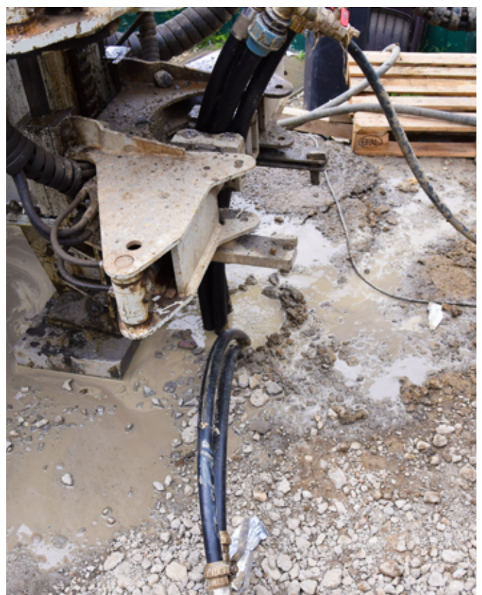
Mit Füllbinder® EWM verfülltes Bohrloch
