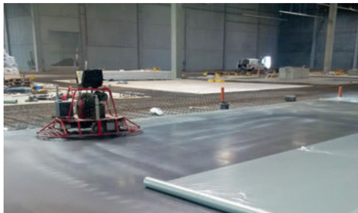
Bild 7: Sofortige Nachbehandlung des Betons nach dem Glätten
