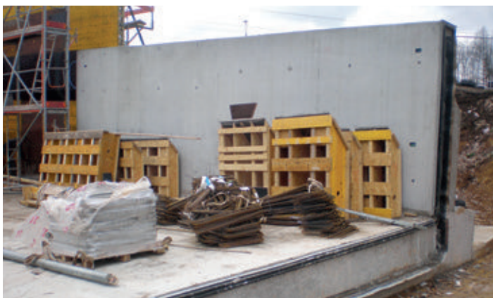
Bild 7: Detail Schalung Trogbauwerk
