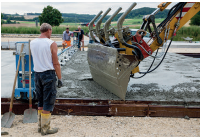
Bild 2: Verdichten und Abziehen der Betonfläche
