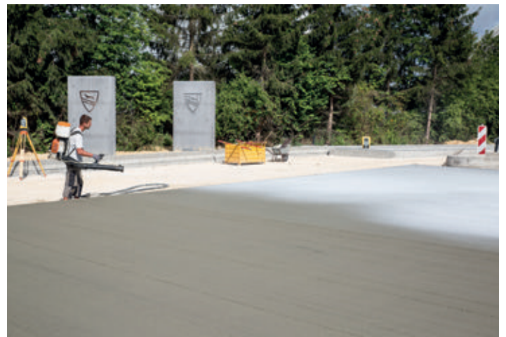
Bild 3: Nachbehandlung mittels Curingauftrag
