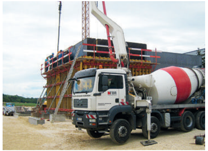
Bild 3: Betonieren mittels Betonpumpe
