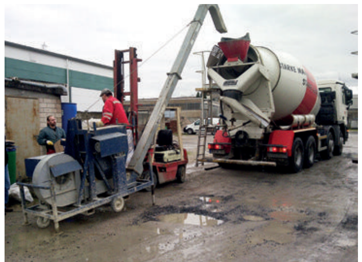
Bild 5: Dosierung der Stahlfasern in den Fahrmischer
