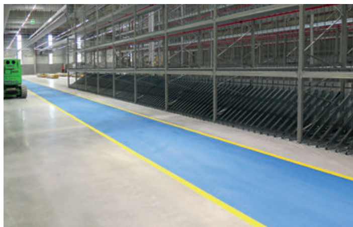
Bild 9: Fertiger Boden noch vor Inbetriebnahme
