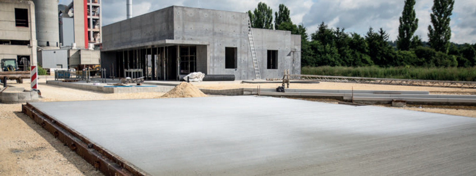
Bild 7: Betonoberfläche mit flüssigem Nachbehandlungsmittel
