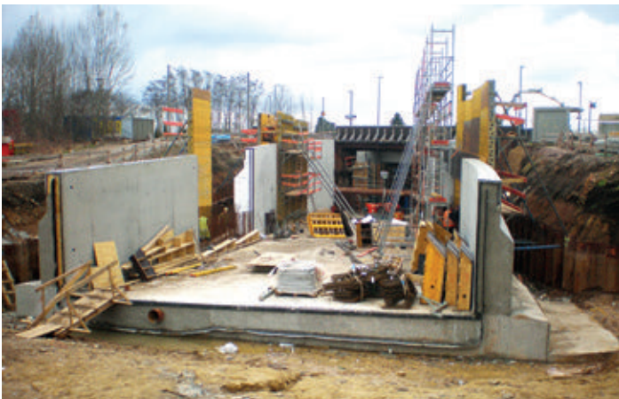
Bild 2: Schalung Trogbauwerk Süd
