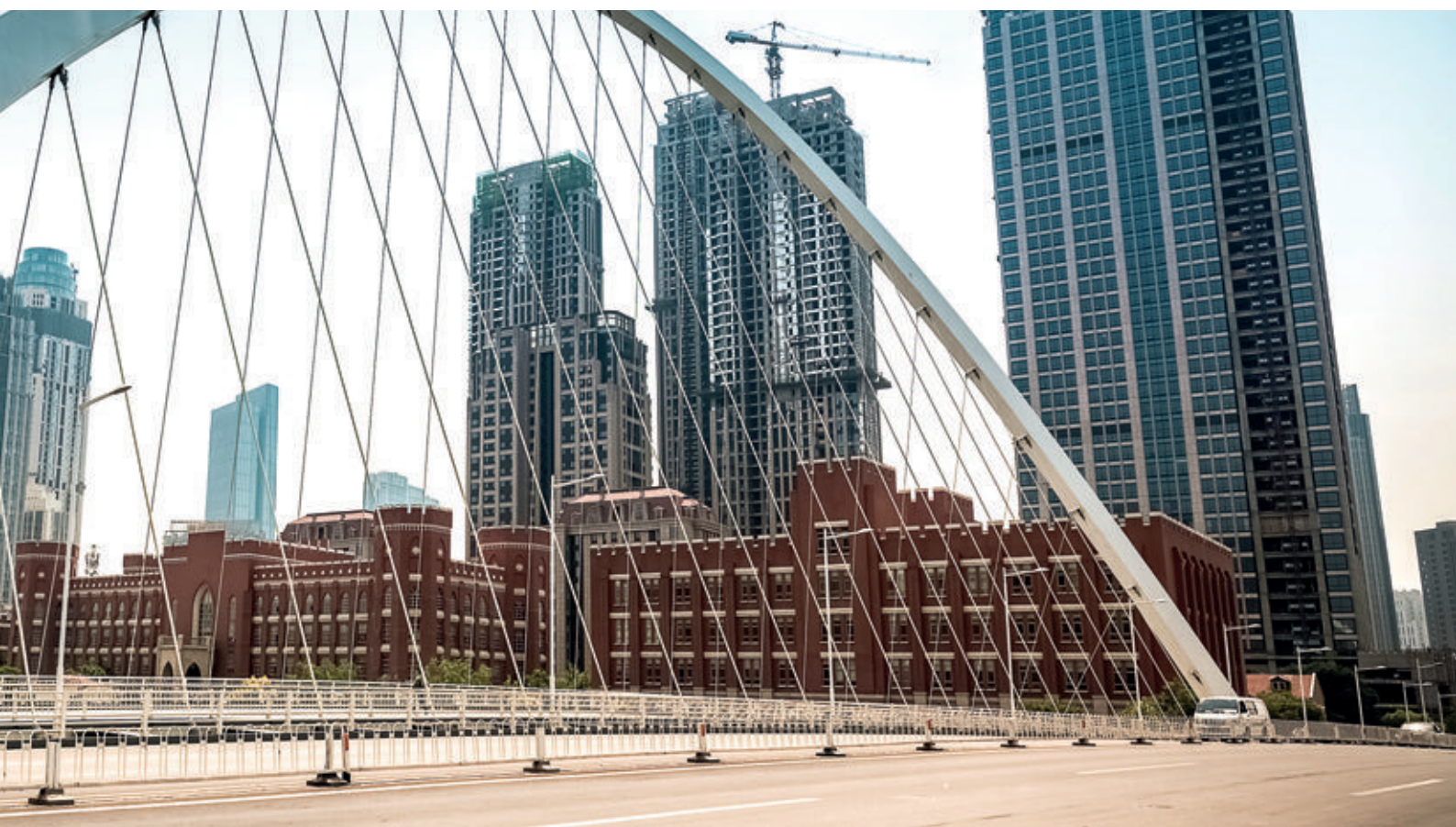
Bild 1: Stadtbrücke in Tianjin, China
