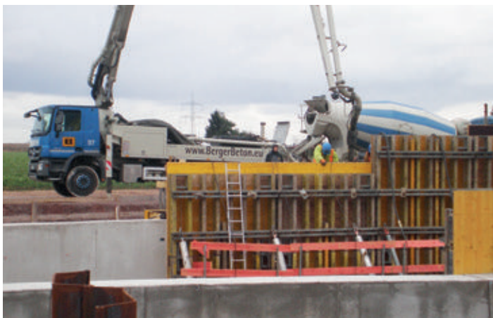
Bild 4: Betonage Trogbauwerk
