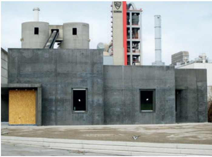
Bild 5: Farbunterschiede vor Oberflächenbehandlung
