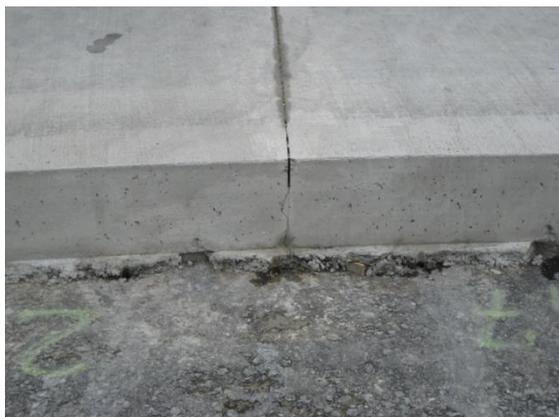
Bild 2: Eingeschnittene Scheinfuge mit Sollriß
