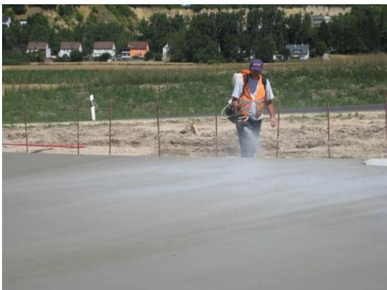
Bild 6: Aufsprühen des flüssigen Nachbehandlungsmittels
