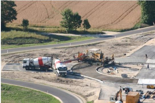
Bild 3: Betoneinbau des Innenrings
