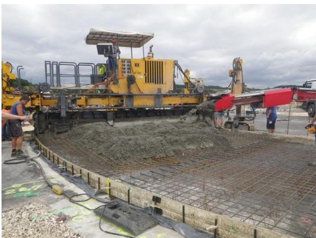
Bild 4: Beschickung des Fertigers durch Förderband
